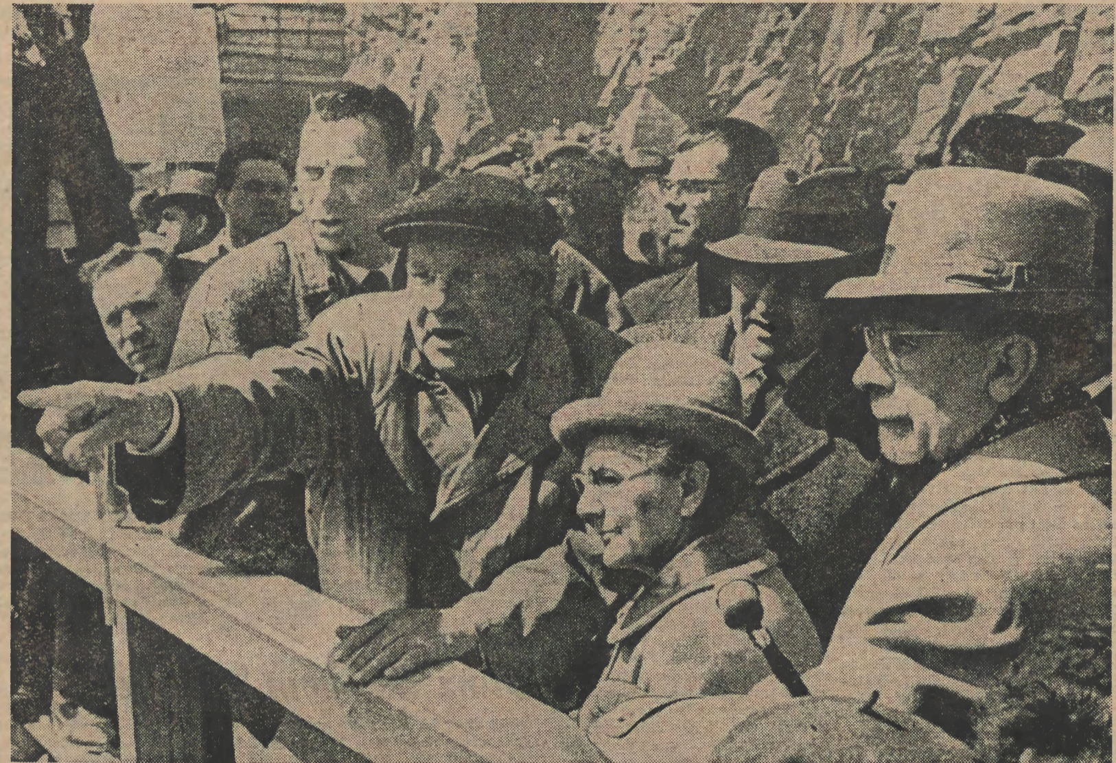
AUF DER BAUSTELLE DES KRASNOJARSKER WASSERKRAFTWERKES. Am zehnten Tag des Aufenthalts in der Sowjetunion haben der Erste Sekretär des ZK der SED und Vorsitzende des Staatsrates der DDR, Walter Ulbricht, und die anderen Gäste aus der DDR den Bauplatz des gigantischen Krasnojarsker Wasserkraftwerkes am Jenissei besichtigt. Der Bauleiter des Wasserkraftwerkes, Andrei Botschkina, erklärte den Gästen die Großbaustelle
