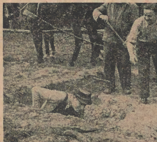
VOR DER ERRICHTUNG DER FREILEUCHTBÜHNE die Kollegen Sedlow und Hubrich beim Stubbenröden
