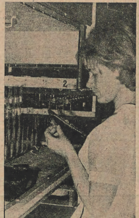
RITA WAND UND IRMGARD FERENZ (RG 2) BEDIENEN DEN PUMPAUTOMATEN II. Sie können heute bereits Schichtleistungen erreichen, die beim manuellen Pumpen unvorstellbar wären.
