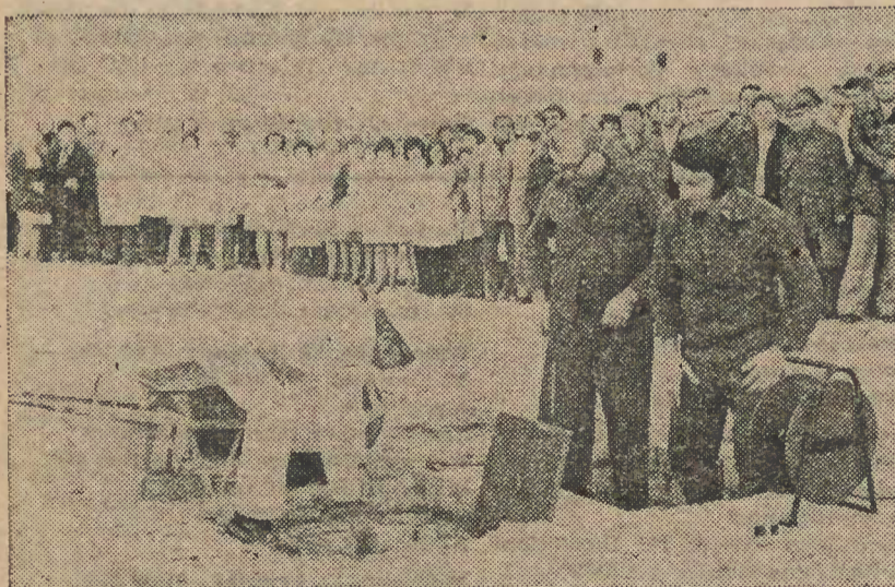
Am 30. September fand die Grundsteinlegung für unsere neue Betriebsgaststätte statt. Somit wurde ein wichtiges Vorhaben zur Verbesserung der Arbeits- und Lebensbedingungen für alle Betriebsangehörigen in Angriff genommen.
