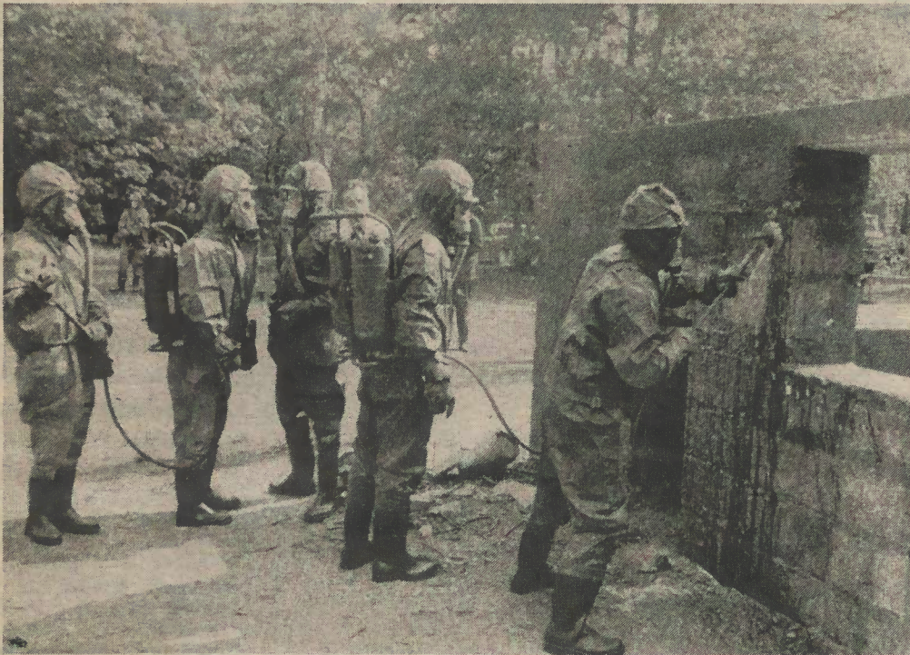
Entgiftungsgruppe bei der Entgiftung einer Hauswand mit TEG
