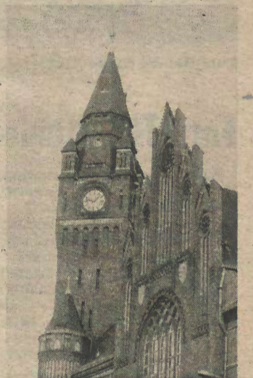
Das Köpenicker Rathaus wurde zwischen 1898 und 1904 errichtet. Damals entstand in der Rosen- und Böttcherstraße der große viergeschossige Winkelbau mit hohem Eckturm, großem Schaugiebel und Eckportal.
