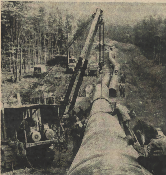
Hochbetrieb an der Erdgasleitung Urengoi—Ushgorod. Rohrlegerbrigade Arkadi Arnstamow verlegt die ersten Rohre im Gebiet Ushgorod.
