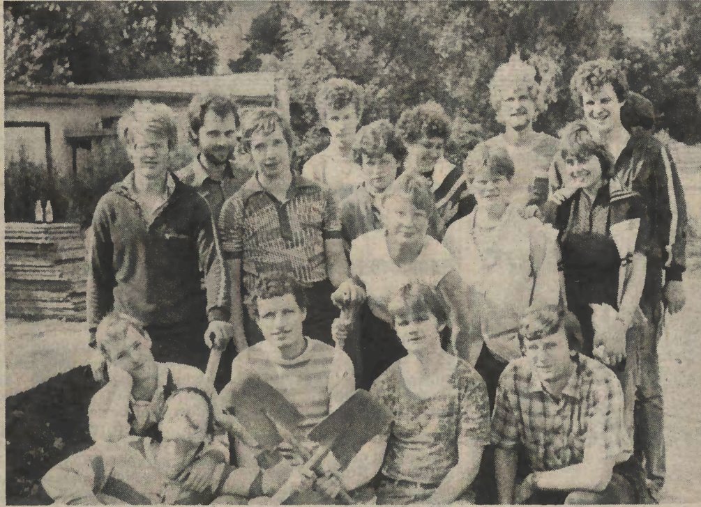
Während des gemeinsamen Subbotniks am vergangenen Sonnabend. Studenten der Technischen Hochschule Ilmenau und FDJler unserer Grundorganisation zogen Kabelgräben für eine neue Lagerhalle.
