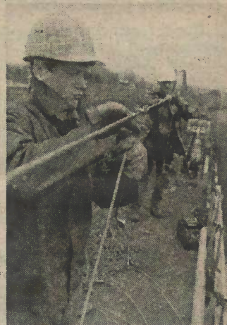
1984 sollen in der DDR 223 Kilometer Strecke elektrifiziert werden. Bis zum Ende des Fünfjahrplanes werden insgesamt 2130 Kilometer Eisenbahnstrecke unter Strom stehen. Auf ihnen rollt dann mindestens ein Drittel der Transportleistungen der DDR ab. Foto: ADN-ZB/Kämpfer
