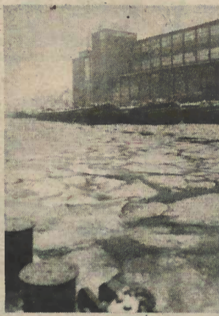
Blick vom Eisbrecher „See-Löwe“ auf das Kabelwerk Oberspree. Die Kerneisstärke auf der Müggelspree beträgt im Durchschnitt 15 cm, bei zusammengeführten Schollen bis zu 23 cm. Der Eisbrecher sorgt für einen ungehinderten Transport für die Industriebetriebe und Heizkraftwerke der Hauptstadt.
