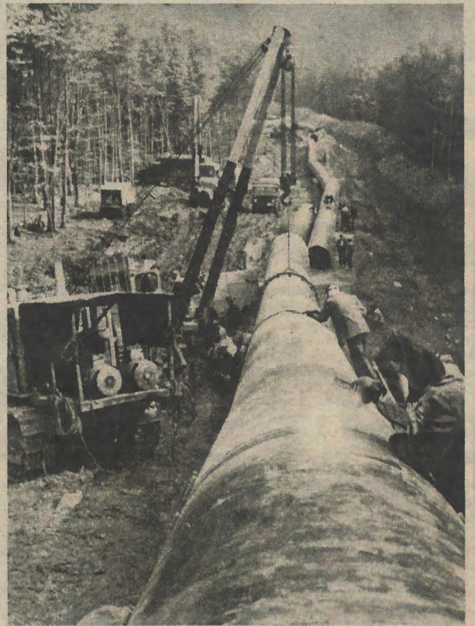
Hochbetrieb an der Erdgasleitung.
