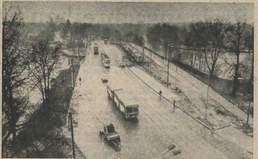
Die neue 63,50 Meter lange und 19 Meter breite Dammbücke am Zusammenfluß von Spree und Dahme in Köpenick ist übergeben worden. Insgesamt sieben Straßenbahnlinien mit 32 Fahrten und zwei Buslinien mit 14 Fahrten in der Stunde passieren die Dammbücke. Für Motorisierte stehen in jeder Richtung zwei Fahrspuren zur Verfügung. Die neue Brücke ist fast viereinhalb Meter breiter als die alte. Mit einer lichten Durchfahrthöhe von 4,70 Meter können alle Transport- und Fahrgast-schiffe die neue Brücke problemlos durchfahren.
