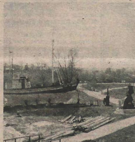
Ein 1901 gebauter 16-Zentner-Dampfschmiedehammer, die 30 m-Slipanlage mit dem 1949 auf der Boddenwerft Damgarten gebauten Kutter „KAR 45“ „Wismar“ von Bord des Traditionsschiffes aus fotografiert.
