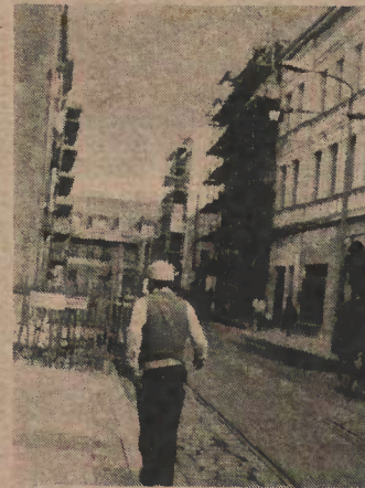
Grünstraße – in zehn Gebäuden wird die Modernisierung bzw. der Neubau von 84 Wohnungen bis Ende Juni '87 beendet.
