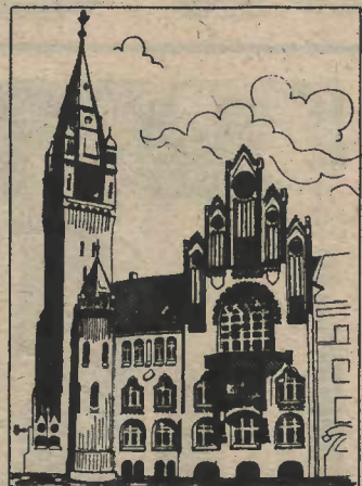
plexannahmestelle des Dienstleistungskombinates.
