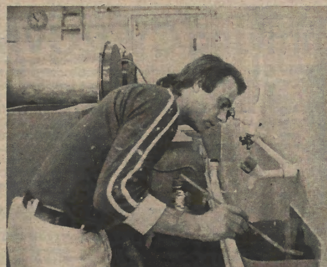
Kurz vor Abschluß der Rekonstruktion in RSF 3. Bernd Prymka verrichtet noch die letzten Malerarbeiten.
