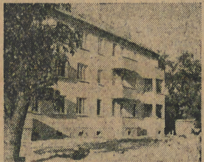
So sieht das fertige Gebäude aus, das bei strahlendem Sonnenschein seine Bewohner erwartet
