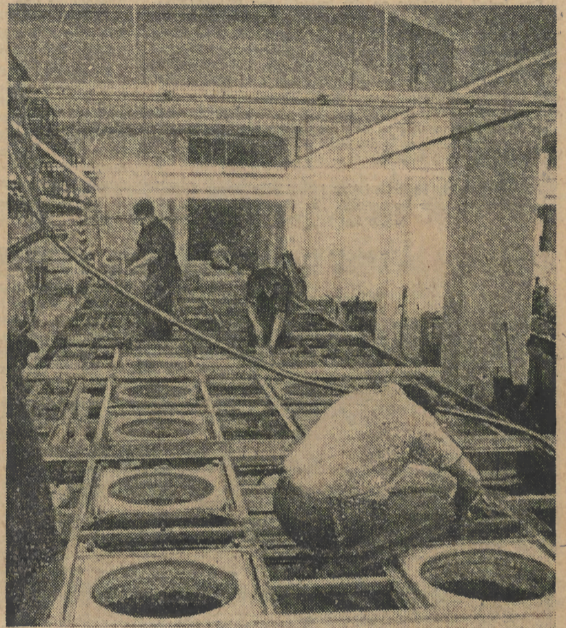
Die neue Taktstraße entsteht
