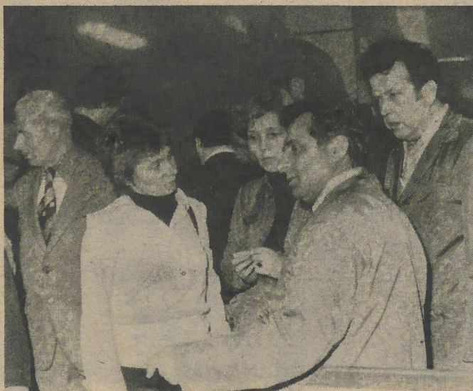
Im Bereich Bildröhren des Tesla-Werkes
