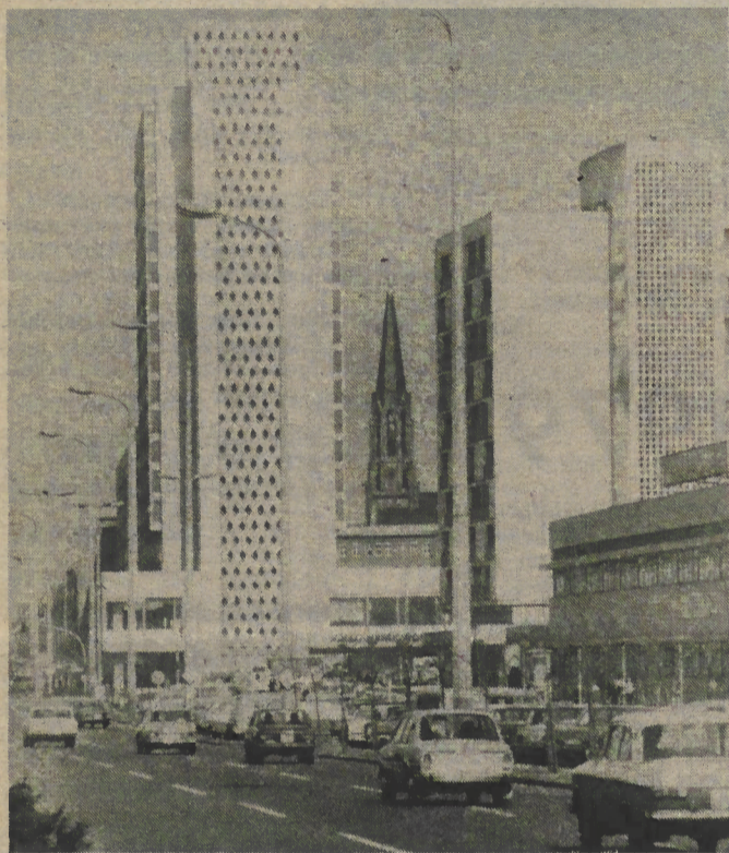
Blick auf die Neubauten in der Hans-Beimler-/Ecke Mollstraße.
