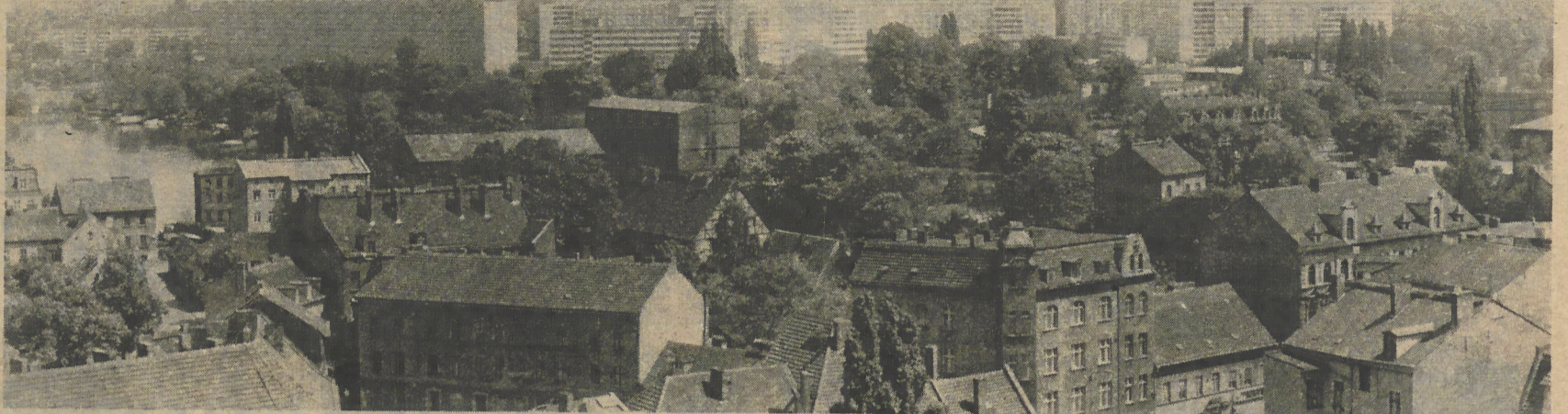
Vom Turm des Köpenicker Rathauses sieht man auf einen Teil der Köpenicker Altstadt und auf das neue Allende-Viertel im Hintergrund.
