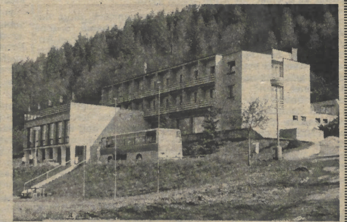
Das Betriebsferienheim „Elektron“ bei Roznow
