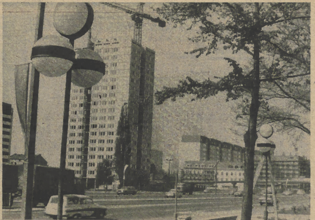
Das erste 17geschossige Hochhaus steht an der Südseite der Straße der Befreiung vor dem Abschluß der Montage. Im Wohngebiet „Straße der Befreiung Nord und Süd“ werden drei solcher Punkthochhäuser entstehen. Bis 1983 sollen dort 3500 Wohnungen entstehen, davon 540 in rekonstruierten, historisch wertvollen Altbauten.
