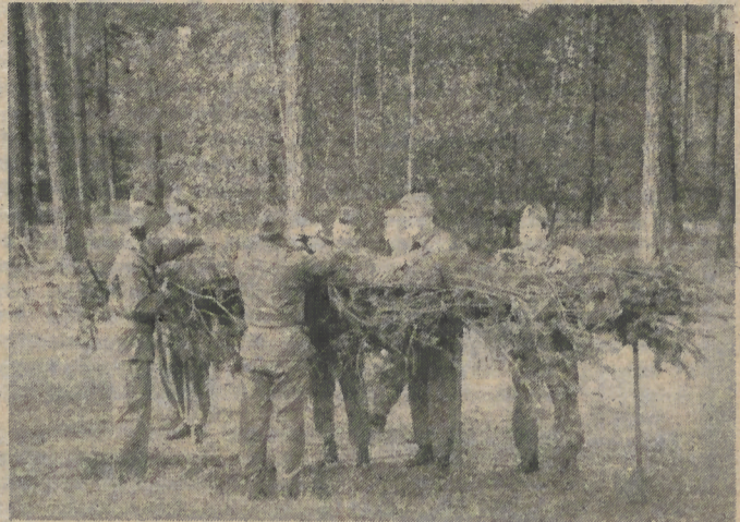
ZV-Einsatzkräfte beim Faschinenbau
