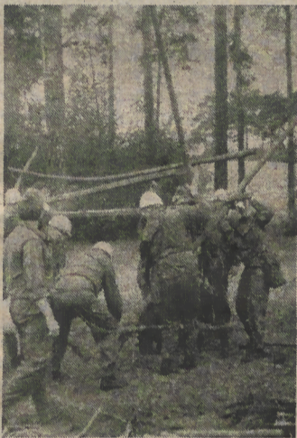
ZV-Einsatzkräfte beim provisorischen Stegbau
