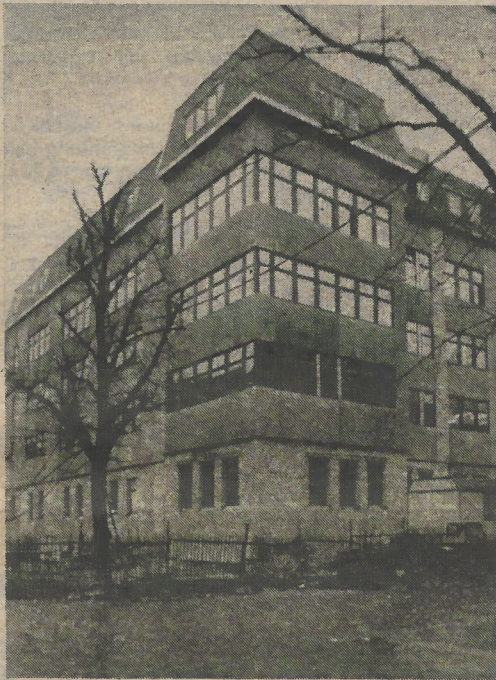
Blick auf den Neubaukomplex der künftigen Gerätefabrik Pankow, die in der Borckumstraße entsteht. Viele Kollegen haben den Hauptsitz des Werkteils Sonderfertigung sicher noch anders in Erinnerung. Entsprechend dem Hauptterminplan wird der Komplexprobebetrieb in diesem Gebäude im Juni 1988 anlaufen.
