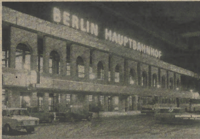
Das neue Empfangsgebäude des Berliner Hauptbahnhofes.
