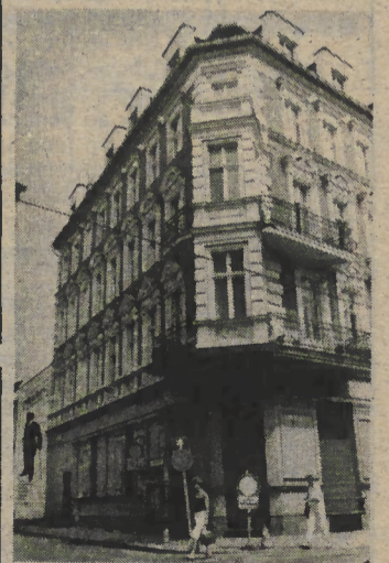
Die neue Fassade dieses Wohnhauses Grün-/Böttcherstraße fotografierte Jens Kalaene.
