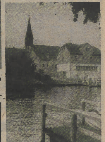
Blick von der Anlegestelle »Spreewiesen« über die Müggelspree nach Rahnsdorf
