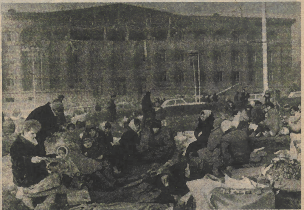
Leninakan nach dem schweren Erdbeben. Foto: ZB
