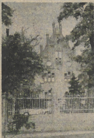
Gebäude des Wasserwerkes
