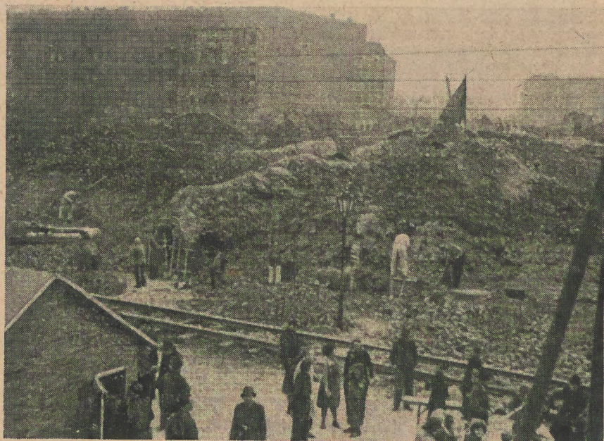
Unsere neue Baustelle: Stralauer Allee, Ecke Danneckerstraße
