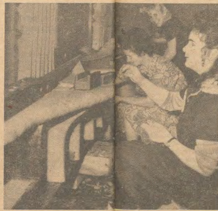
Zur Zeit der Aufnahme waren dünnen des Spulenaufbaus beim Preßeisenisolieren des ersten 100afos für Lübbenau. Inzwischen sind die Kollegen der Brigade Me der Weiterführung der Arbeiten, d. h. beim Spulenaufbau auf 11.
