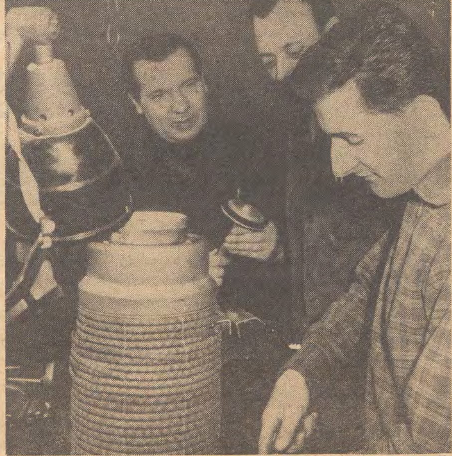
Ihr ganzes fachliches Können sowie ihren Fleiß legen die Kollegen und Genossen der Brigade „Ernst Thälmann“ in die Montagearbeiten beim Baukastenschalter. — Auch dieses Kollektiv hat sich das Ziel gestellt, in diesem Jahr die staatliche Auszeichnung ein weiteres Mal zu erhalten
