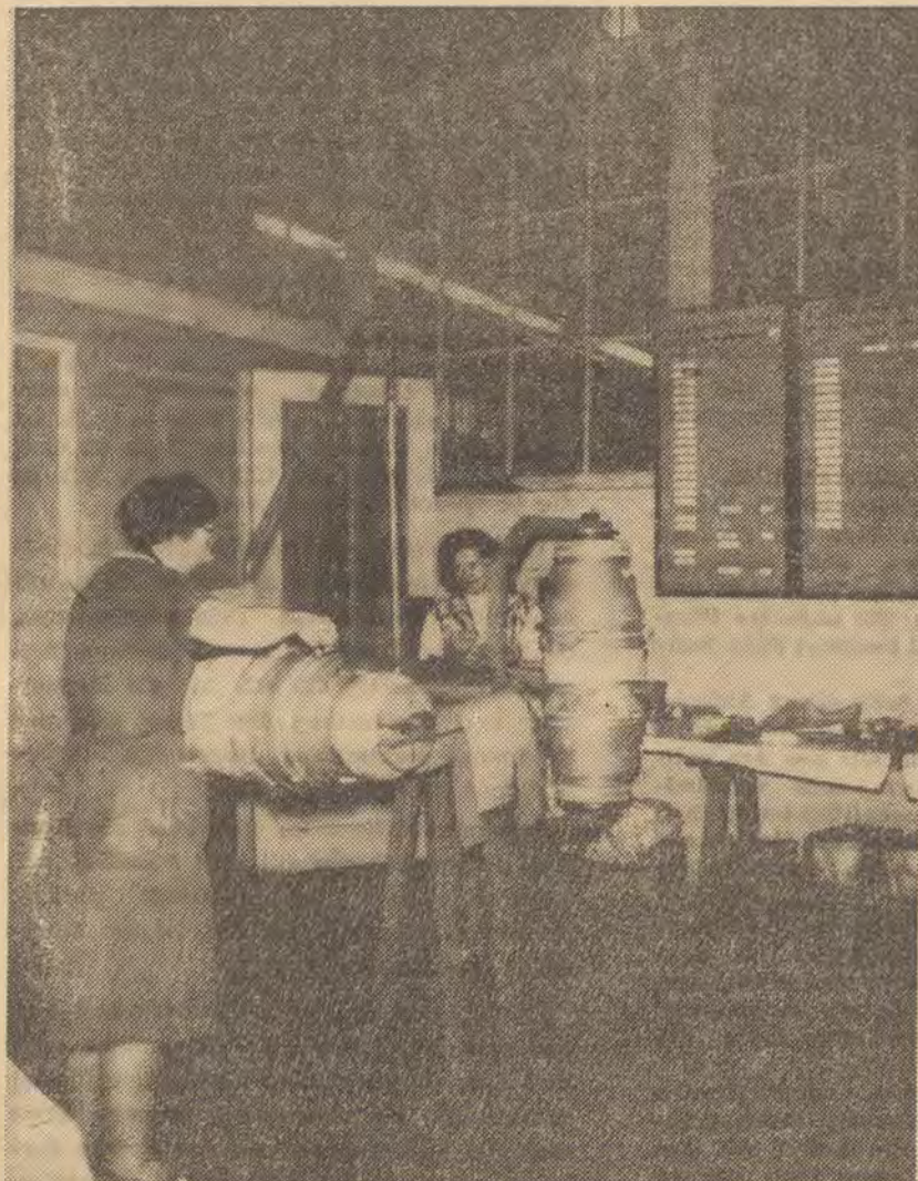
Die Kolleginnen Ursula Otto und Käte Herzig aus der Brigade „Anne Frank“ in Rummelsburg trafen wir bei Reißarbeiten am Spannungswandler an. In der Brigade wird mit Optimismus an der Planerfüllung des IV. Quartals 1964 gearbeitet.
