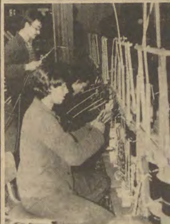
50 kVA-Trafos werden geschaltet.
