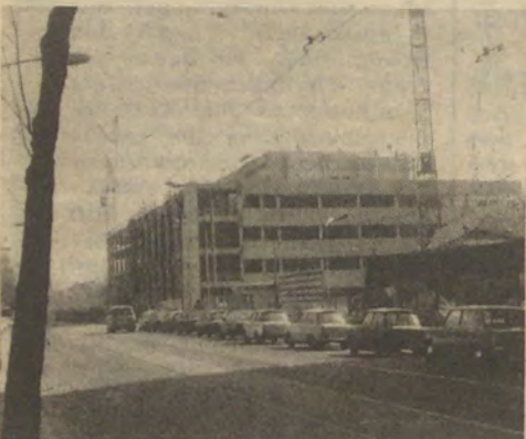
Nur wenige hundert Meter vom Hauptwerk entfernt entsteht ein neuer Gebäudekomplex des WF.
