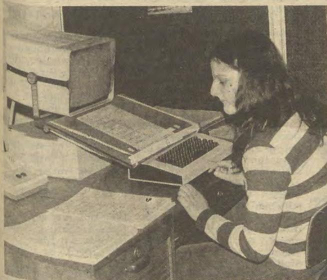
Reingeguckt in den O-Betrieb: Gekoppelt wurde hier der Rechner PR 4000 mit dem Bildschirmsystem BSS 21. Die Zeit der Auftragsvorbereitung konnte durch das Schreiben und Vervielfältigen der A- und F-Blätter auf der elektronischen Schreibmaschine „Robotron S 6001“ von vorher vier bis sechs Wochen auf drei Tage verkürzt werden.
