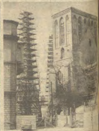
Unweit des Roten Rathauses befindet sich das älteste Bauwerk Berlins, die Nikolaikirche. Noch stehen die beiden Turmhelme vor der Kirche. Die erforderlichen Maurerarbeiten im Turm und die Stahlbetonarbeiten auf der Mauerkrone des massiven Turmteiles sind abgeschlossen. Wenn die Dachklempnerarbeiten an den Turmhelmen beendet sind, werden die Helme aufgesetzt.
