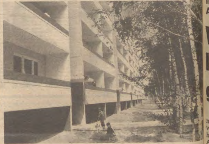
Wohngrün von Anfang an haben die Bewohner des Müggelschloßchenweges und der anderen neuen Straßen des erweiterten Allendeviertels in ihrer unmittelbaren Umgebung Klug haben die verantwortlichen Bauleute nur Baumbestände entfernt, die für Bauten und Transportwege unbedeutend waren.
