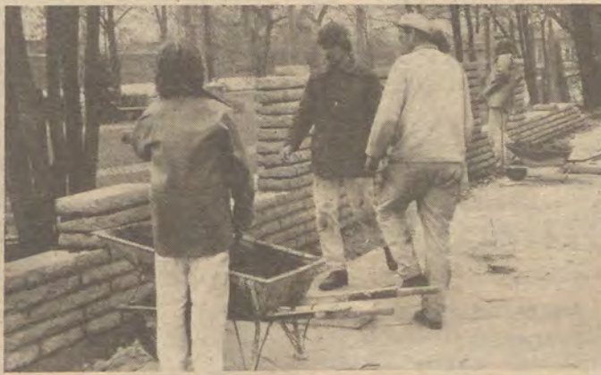
Jugendbrigade „Bau“: Wichtigstes Objekt und zugleich MMM-Vorhaben aus dem Plan Wissenschaft und Technik ist für die zehn Lehrlinge der Anbau Halle 100. Ihr Ziel: termingerechte Übergabe.
