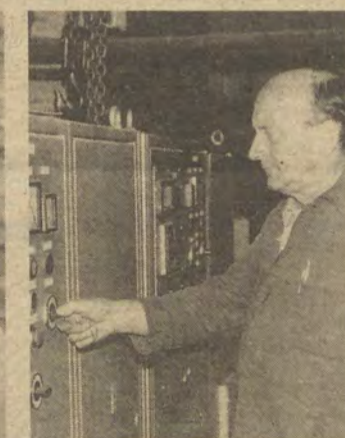
Gustav Beischer, TAT/Ra, hat als Brigadier und Klempner großen Anteil an der schnellen Beseitigung der Havarie am Vorkumpumpensatz der Paraffintrocknungsanlage.
