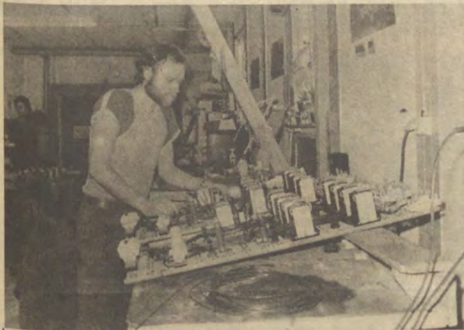
15 Schalttafeln für TVW-Bausteine monatlich zu verdrahten, haben sich die Elektriker der Abteilung NT vorgenommen. Mit dieser zusätzlichen Initiative wollen sie ihren Beitrag zur Planerfüllung 1982 leisten. Auf unserem Foto: Kollege Bernd Thiele.
