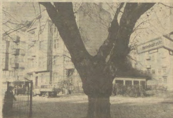
In der Helmholtzstraße sind die Köpenicker Bauleute noch am Werk. Auch hier werden die alten Häuser modernisiert, allerdings sind die Mieter hier nicht ausgezogen, erleben die Bauarbeiten so aus allernächster Nähe mit.
