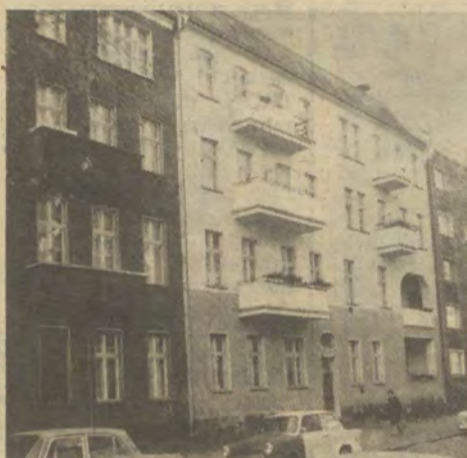
Schmuck sehen die alten Häuser in der Fritz-Kirsch-Zeile in Oberschöne-weide aus. Ihr Alter sieht man ihnen von außen und von innen nicht mehr an. Alle Wohnungen erhielten im Zuge der Rekonstruktion Bad und IWC.
