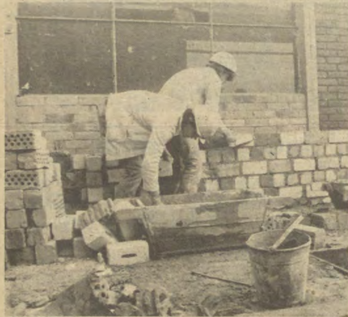
Ein Jugendobjekt im T-Bereich: der Anbau Halle 100. Hier arbeiten vor allem Maurerlehrlinge
