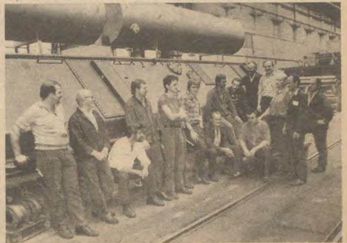
Zu den besten Kollektiven des Transformatorenbaues unseres Werkes gehört das sozialistische Kollektiv „Roter Oktober“ der Endmontage.
