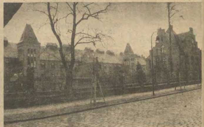
Wer kennt es nicht, das alte Wasserwerk in Friedrichshagen?
