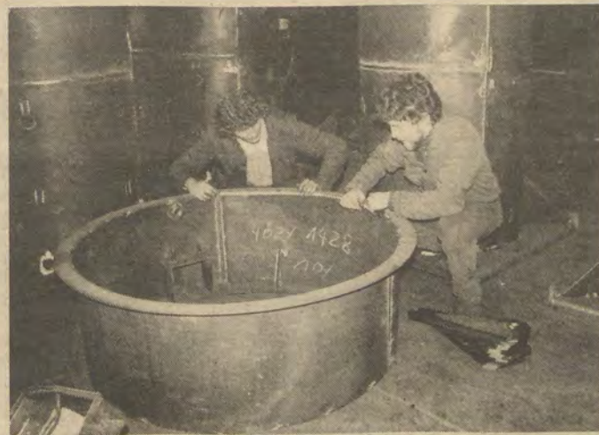
Ebenfalls zur FDJ-Gruppe NFB gehören Stefan Schmatter und Roland Fritsch. Beide sind Schlosser, hier beim Anreißen eines Teils für einen Gastransportbehälter.
