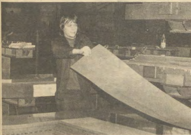
Genosse Bernd Schuster arbeitet als Kernschichter im Kernbau des Großtrafobaus.
