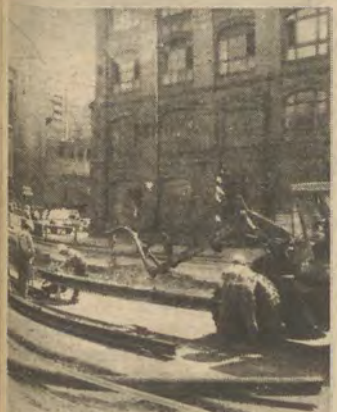
Zügig voran gehen die Bauarbeiten an der Kreuzung Wilhelminenhofstraße/Edisonstraße.
