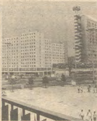
Zügig voran gehen die Bauarbeiten an der Liebknecht-/Ecke Luxemburgstraße
